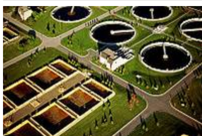
Une station de traitement des eaux usées.
